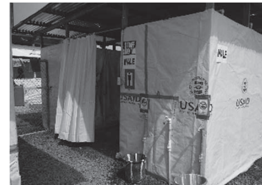
図3 エボラ治療ユニット内の簡易トイレの入り口：手洗いは0.05%次亜塩素酸ナトリウム消毒液の蛇口（青）と、手洗い以外に利用する0.5%次亜塩素酸ナトリウム消毒液（赤）の蛇口にわかれている。
