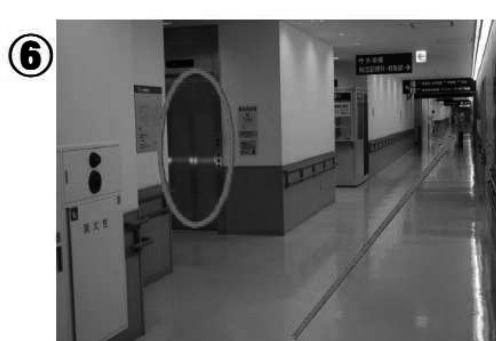
このエレベータも通り過ぎて下さい。
